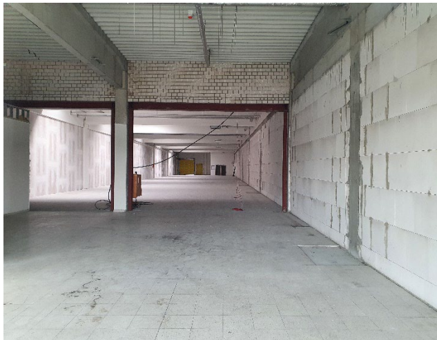
Bei unserem Kauf war die Fläche im Rohbau-Zustand
