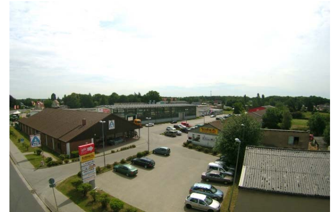
Gesamtobjekt vor dem Umbau
