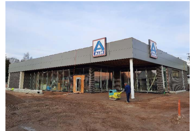
... das Gebäude ist aber schon so gut wie fertig
