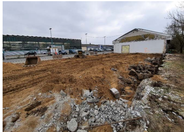
Teilabriss von Gebäude II für verlegte Zufahrt/Stellplätze
