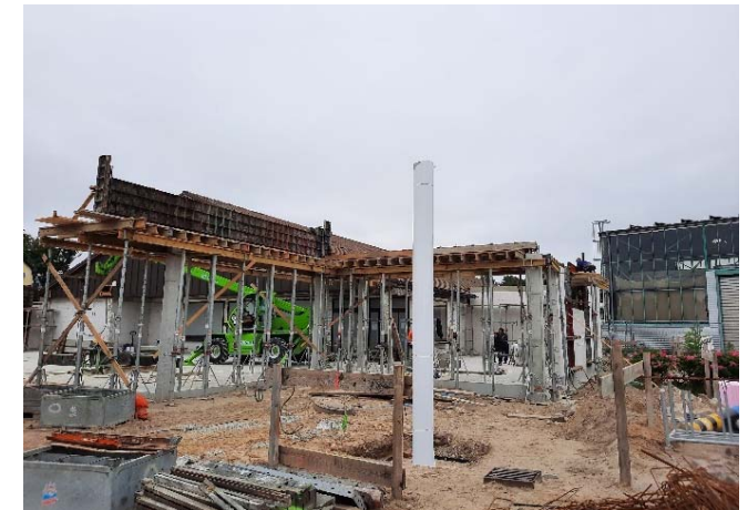
Hier wird der neue Eingangsbereich geschaffen
