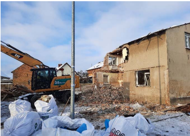
Abriss des leerstehenden Wohnhauses
