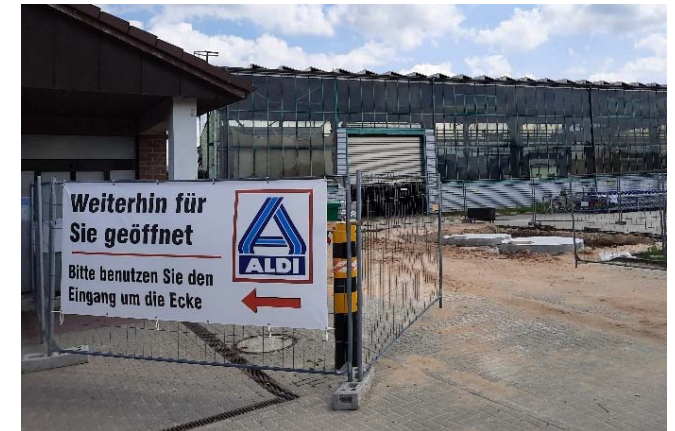
Der Umbau erfolgt im laufenden Betrieb
