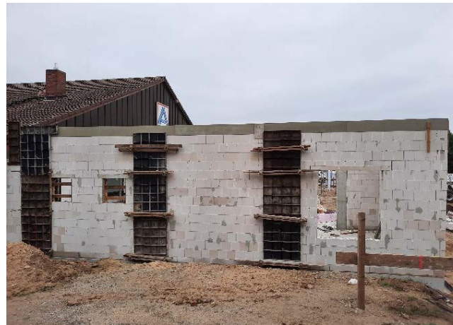
Auch die Außenwände des Anbaus stehen schon
