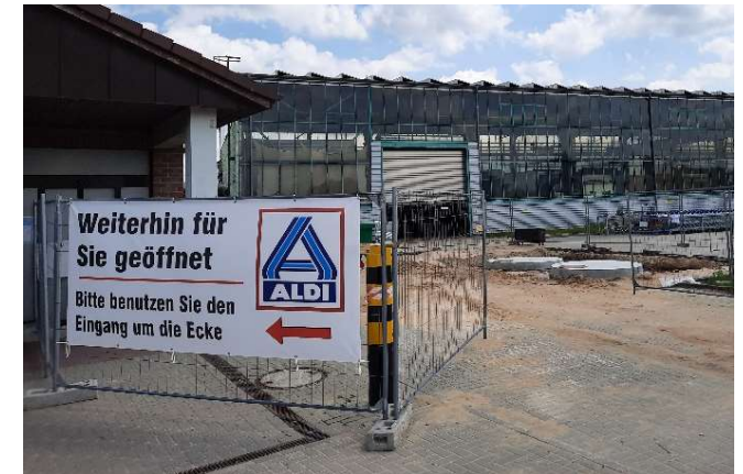
Der Umbau erfolgt im laufenden Betrieb
