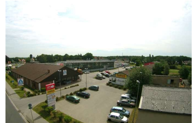
Gesamtobjekt vor dem Umbau
