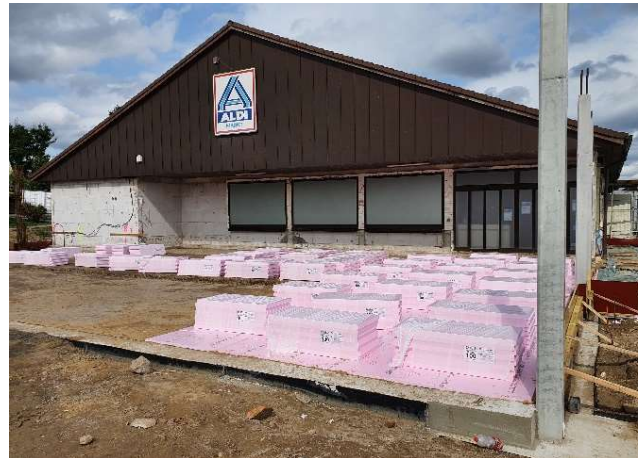
Hier entsteht das Fundament für die ALDI-Erweiterung
