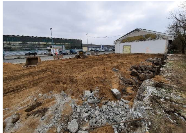
Teilabriss von Gebäude II für verlegte Zufahrt/Stellplätze
