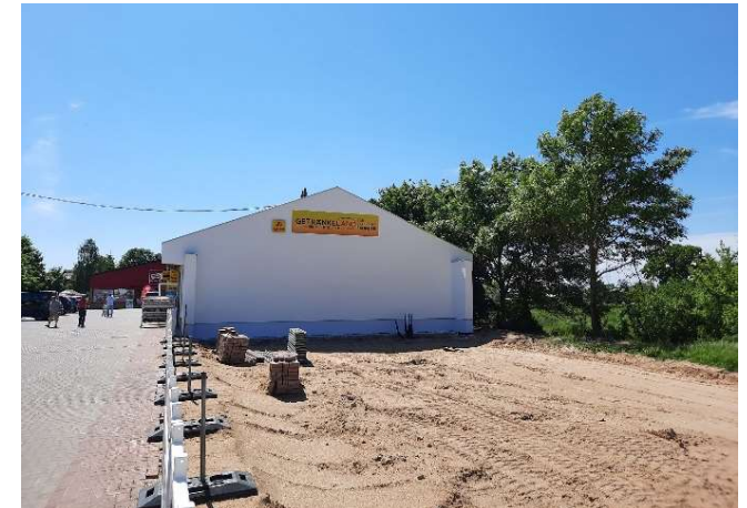
Neue Fassade am Gebäude II
