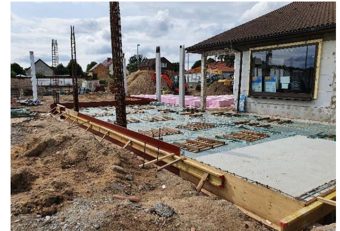
Einige Stützpfeiler des Anbaus sind schon erkennbar
