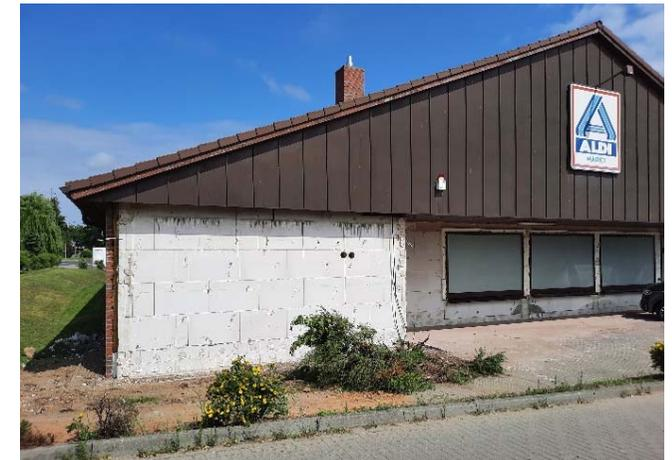
Die Verklinkerung an der ALDI-Fassade wurde entfernt
