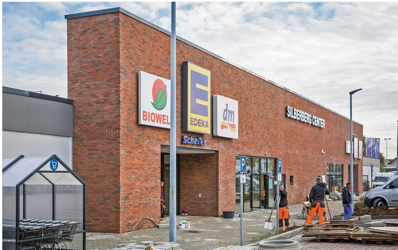
Nur noch wenige Stunden, dann öffnet das neue Silberberg Center in Radeberg. Handwerker arbeiten mit Hochdruck an der Fertigstellung.
