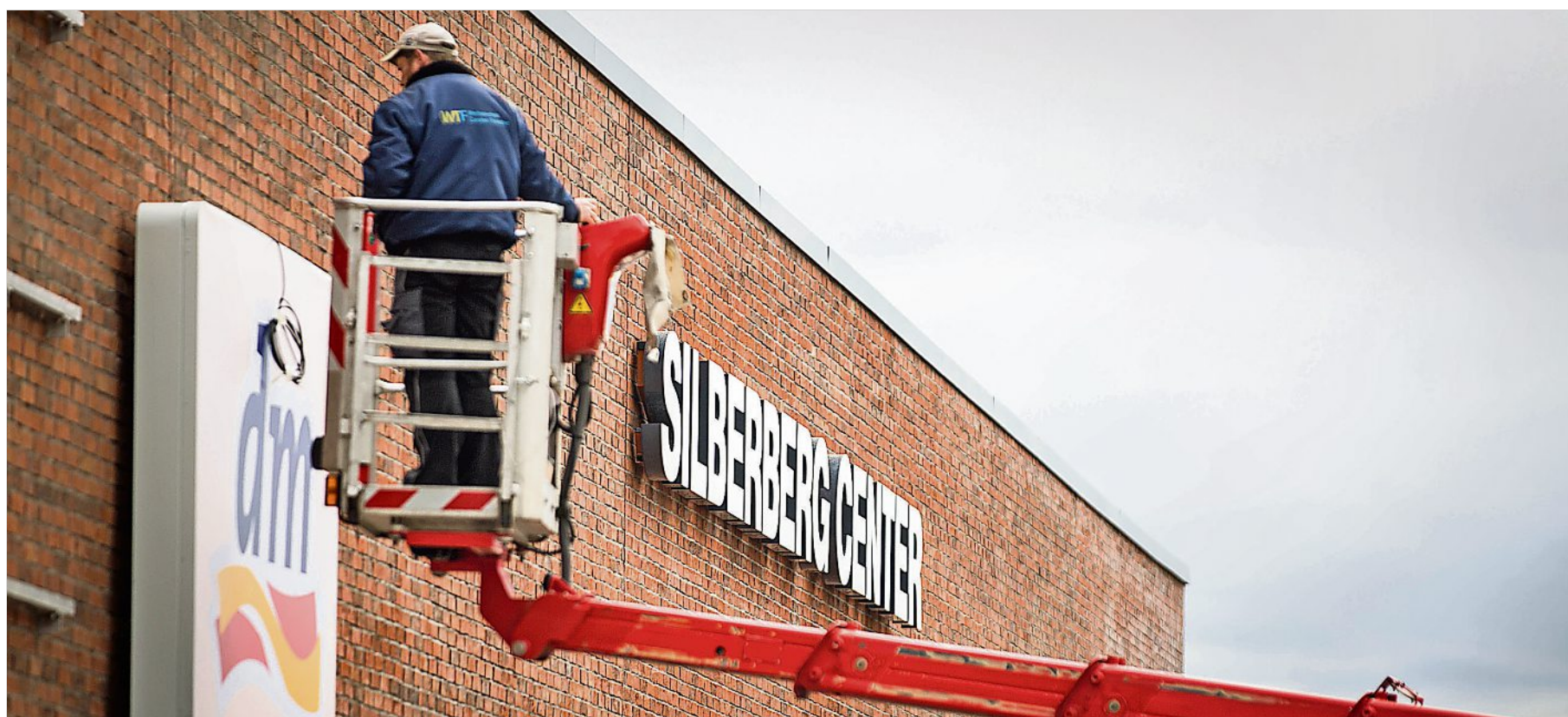
Letzte Arbeiten am Silberberg Center in Radeberg: Die Filialen bringen die Logos an der Fassade an. Am 5. November findet die Eröffnung statt.
