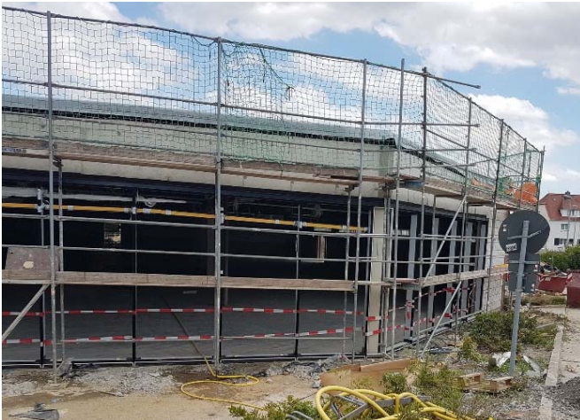
Rohbau vergrößerte ALDI-Fläche von außen ...
