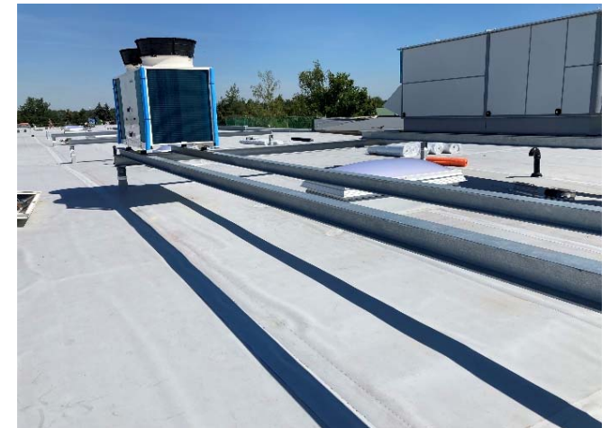
Erneueres Dach mit aufgebauten technischen Anlagen
