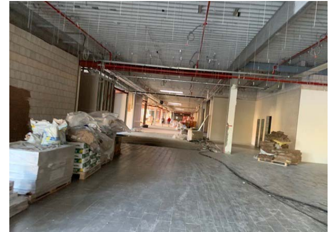
Neue Mall in Blickrichtung von ALDI zu EDEKA
