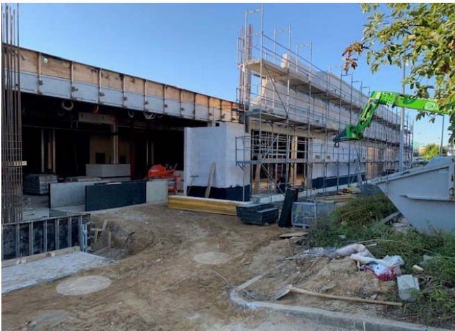
Rohbau der neuen hohen Fassade von vorne ...
